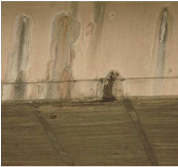
*Imagen No 13: Se observa las manchas y eflorescencias producidas por la humedad que se presentaba en el puente del puente circunvalar.*
