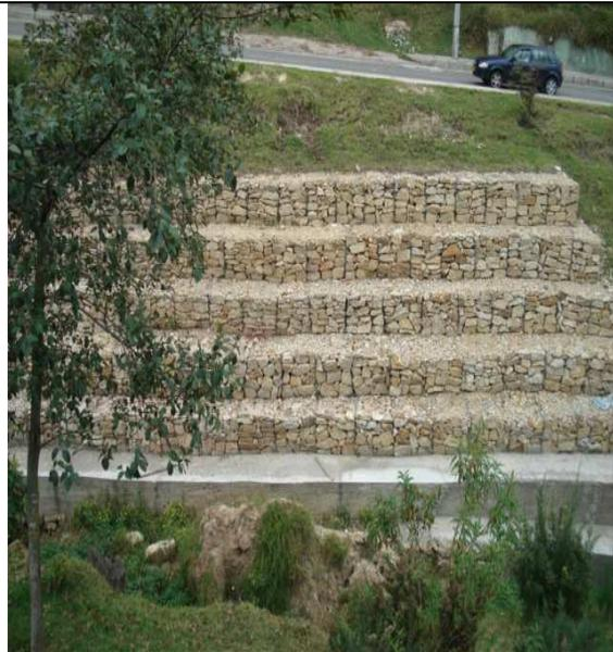
*Imagen No 16: Otros de los sectores, en los cuales se construyó muros en gaviones, para mitigar los problemas de erosión, en el talud de la Quebrada Las Delicias.*
