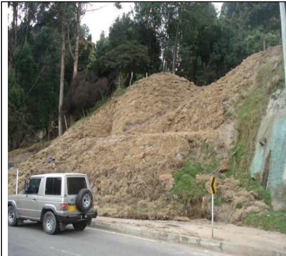
*Imagen No 11: Talud con recubrimiento de pasto totalmente seco, por el sistema de trinchos.*
