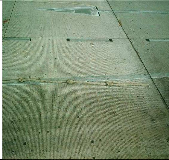
*Imagen No. 6: Fisuras inyectadas en vía plataforma No. 2 portal*
